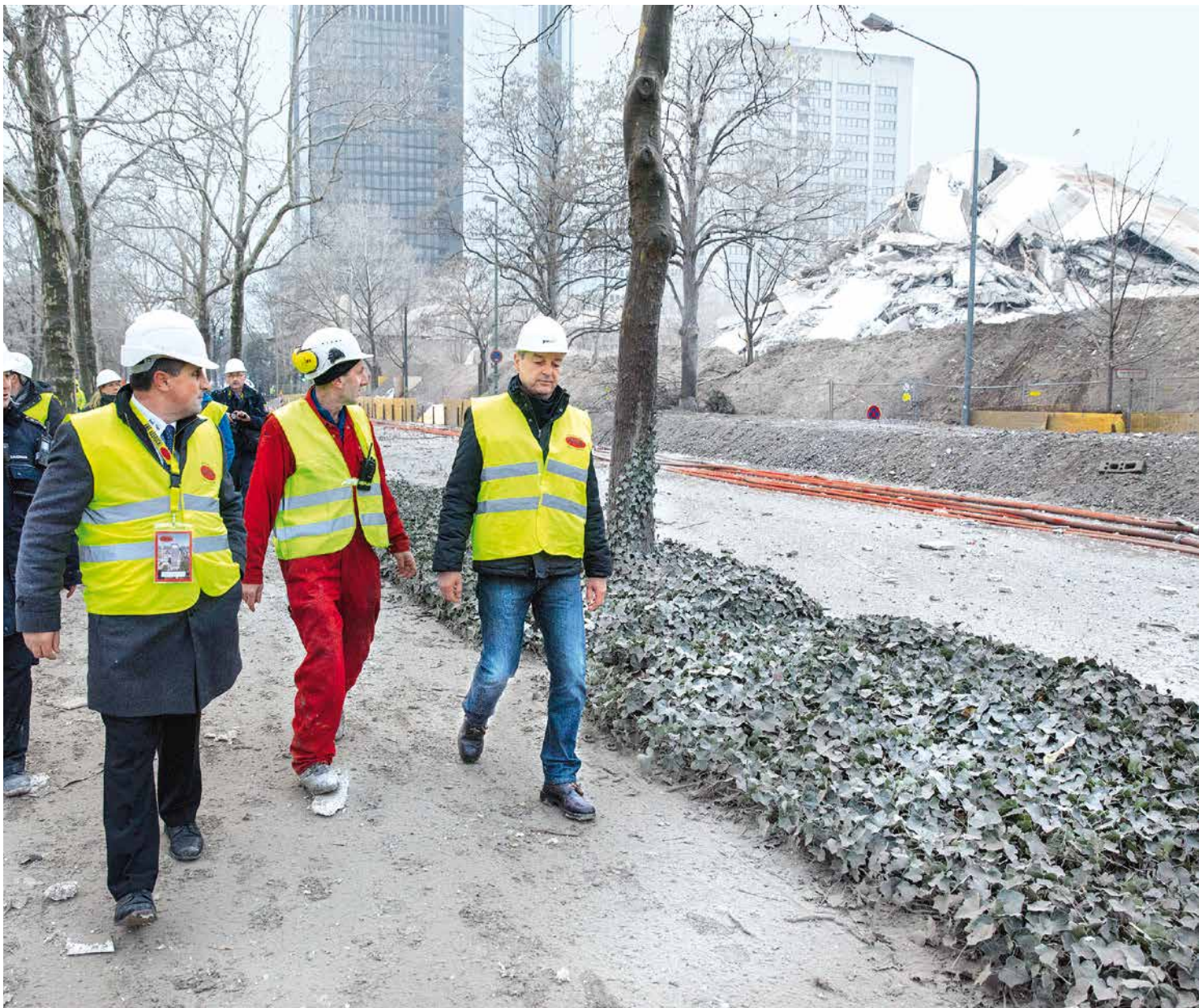
Nach der Sprengung - Ilmi Viqa, Eduard Reisch und Frank Junker auf dem Weg zu den Trümmern.
